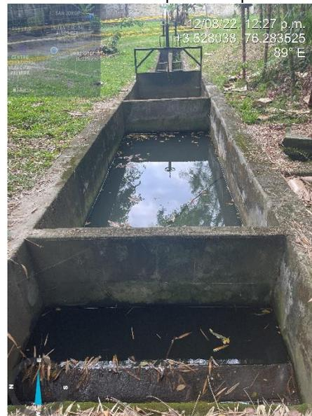
Figura 99. Desarenador, compuertas, canales
