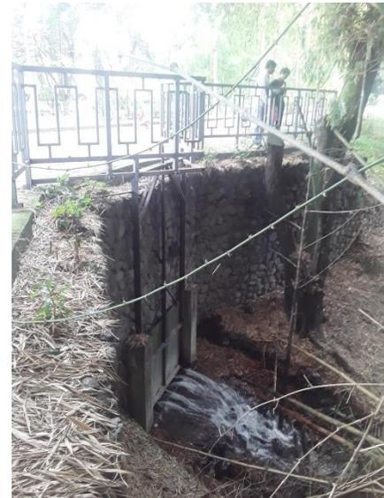
Figura 103. Compuerta de conexión entre lago y río Palmira
