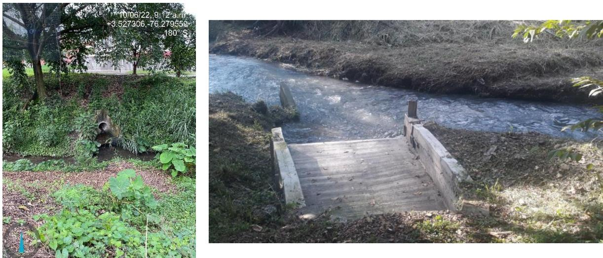
**Figura 86.** Descargas del sistema de alcantarillado pluvial del municipio a los hoy drenajes urbanos
