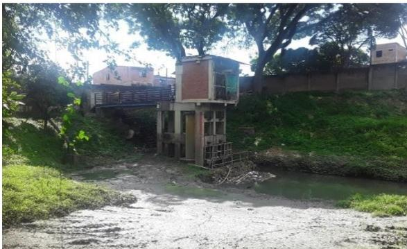
Figura 104. Inicio box culvert río Palmira (rejilla, bocatoma, estación de bombeo y caseta de operación)
