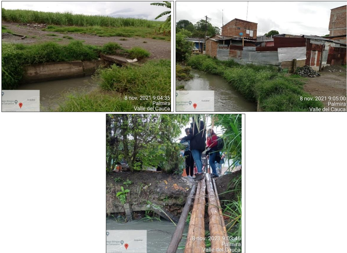
Figura 92. Paso del río Palmira por el sector. Fuente: elaboración propia.
