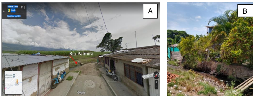
Figura 89. Sector Callejón de Los Roa, corregimiento Guayabal. A. Imagen del 2013, Callejón de Los Roa. Margen derecha del río sin vegetación, al fondo cultivo de caño B. Imagen tomada desde la margen izquierda del río Palmira, el 4-10-2021. Se puede observar plantas sembradas por la comunidad, escombros y un paso improvisado Fuente: Google Maps, 2013 y DGRD Palmira, 2021.
