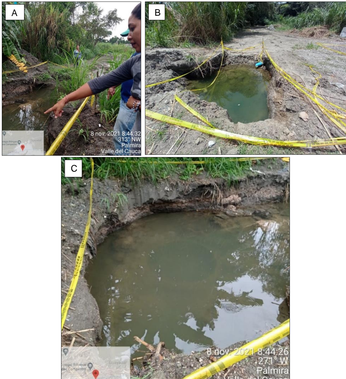
Figura 91. Zanjas de colector sanitario PTAR, predio al lado derecho del Sector de Los Roa. Las imágenes A y C, son en la actualidad las franjas del colector sanitario para la PTAR. La imagen B, corresponde a una de las zanjas de las tuberías tomadas por un funcionario de la DGRD en la visita del 4 de octubre del 2021.
