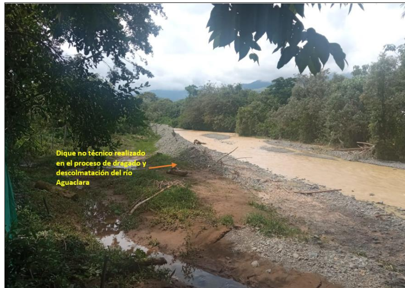
Figura 96. Obra no técnica realizada a la margen derecha del río AguaClara. Fuente: elaboración propia.
