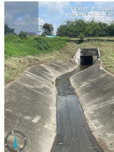
**Figura 88.** Zanjón Mirriñaio revestido en concreto barrio Mirriñaio
