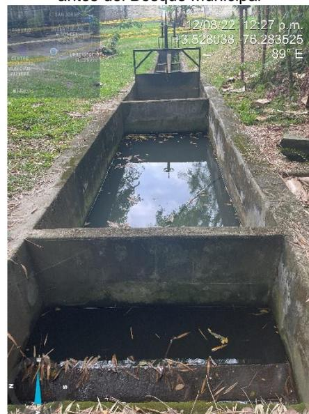
Figura 99. Desarenador, compuertas, canales
