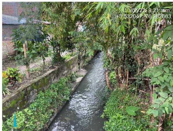
Figura 95. Proceso de erosión de orilla con muro fracturado en la calle 35 río Palmira
