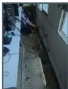
Foto 13 – 14 – 15 – 16 : Instalación de cableado, Instalación de canaletas, ajuste de tapas, instalación de routers.
