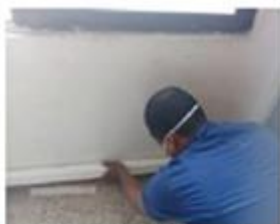
Foto 10: Instalación Canaletas
