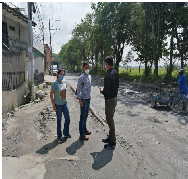
Estado de vía: no hay andenes ni drenaje pluvial, la comunidad rellena los huecos.
