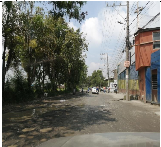
Servidumbre de acceso, con usos deportivos y de vivienda.
