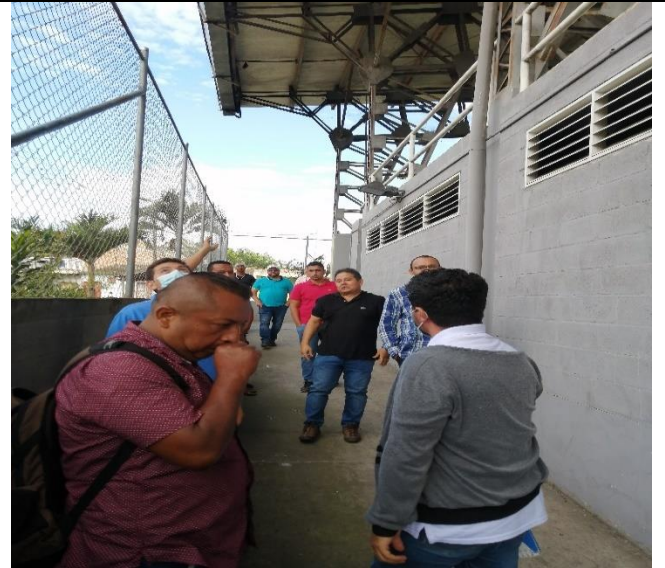
Verificación de todos los detalles de deterioro del CIC CORONADO.
