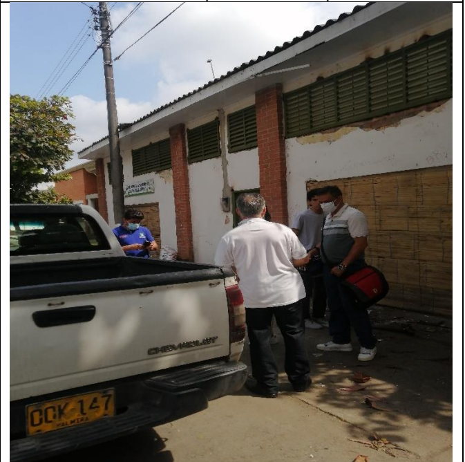
En el deterioro también se observa cómo se cae el cielo falso.
