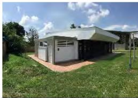
Foto N° 12: Estado Final de las Caseta Comunal
