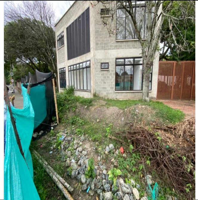
Todavía hay escombros de obra frente a la edificación, poco mantenimiento en este sector.
