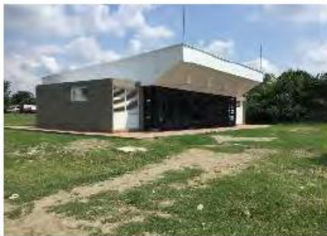
Foto N° 11: Estado Final de las Caseta Comunal
