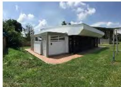
Foto N° 12: Estado Final de las Caseta Comunal
