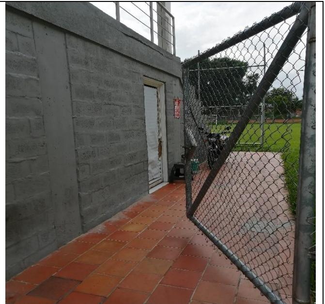
Buen estado del cerramiento y funcionando.
