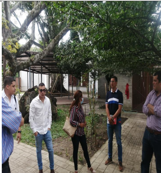
Se presenta deterioro en el concreto por señales de humedad.
