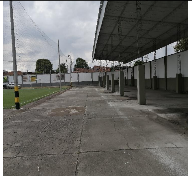
Edificación de los camerinos, se observa red eléctrica con transformador con buena capacidad para conexión de energía.
