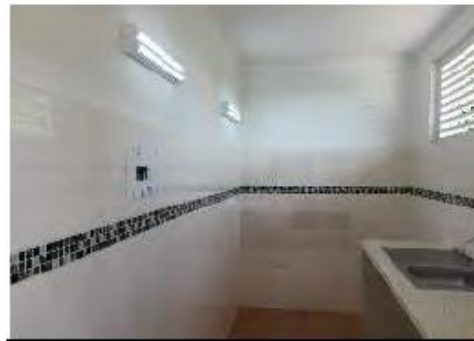
Foto N° 10: Estado Final de la Cocineta
