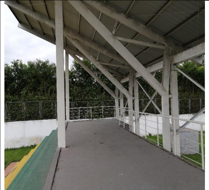
La gradería se observa en buen estado.
