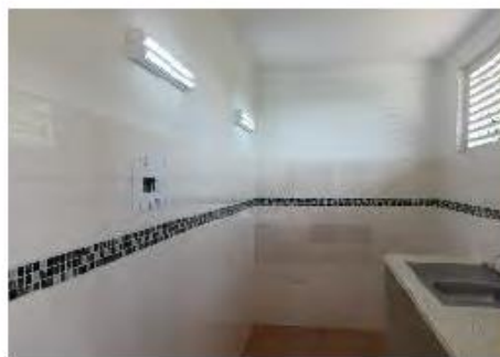
Foto N° 10: Estado Final de la Cocineta
