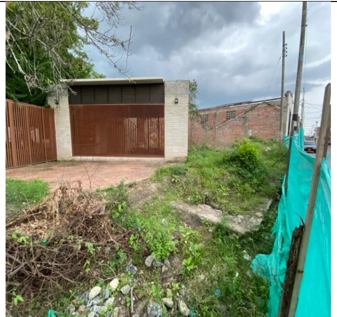
Escombros frente a la edificación,
