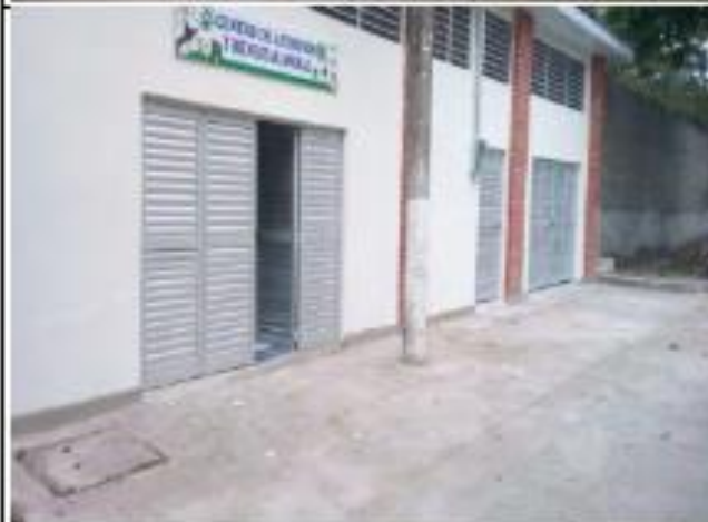
Foto No. 6 Fachada
