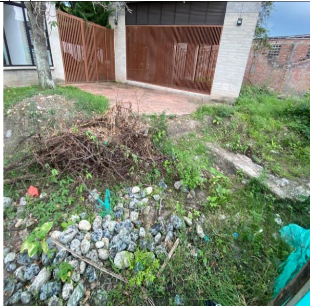
No hay un buen mantenimiento y limpieza hacia el frente del equipamiento.
