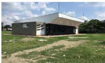
Foto N° 11: Estado Final de las Caseta Comunal
