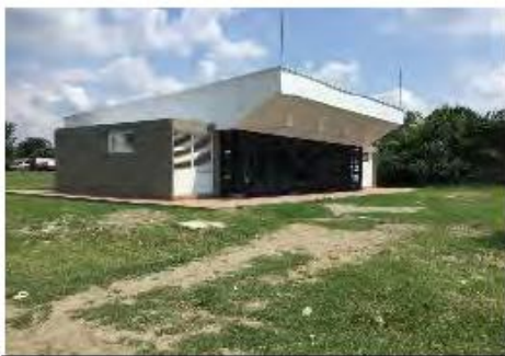
Foto N° 11: Estado Final de las Caseta Comunal
