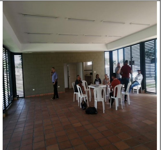
Se observa el estado de deterioro de los pisos en tablón.
