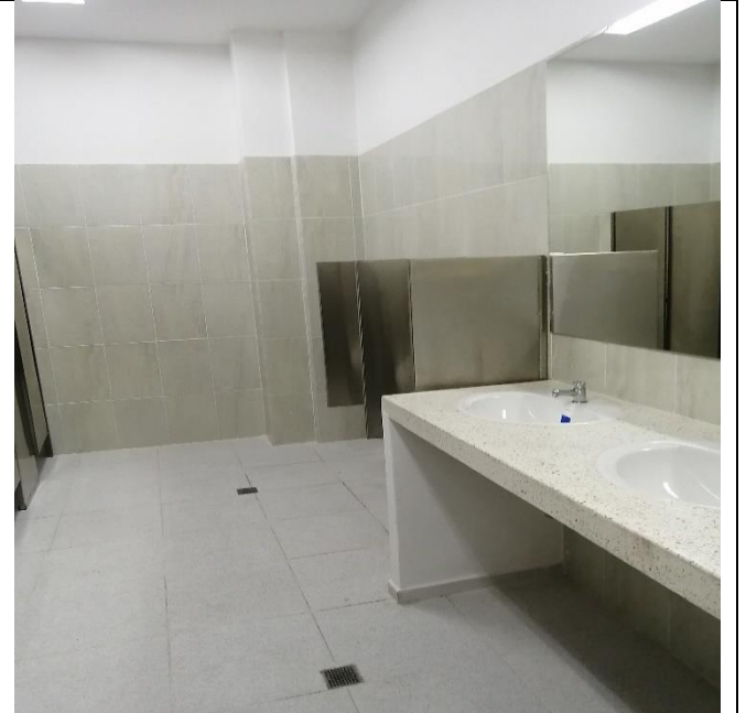
Áreas de los baños completas y funcionando.
