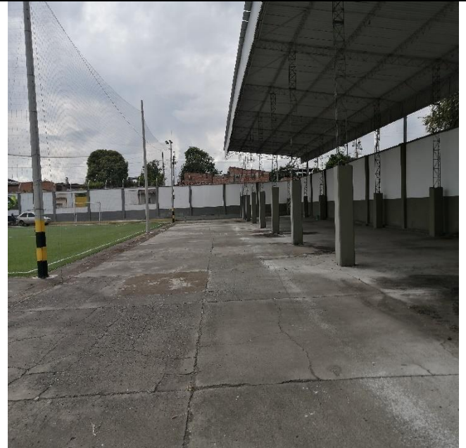
Edificación de los camerinos, se observa red eléctrica con transformador con buena capacidad para conexión de energía.
