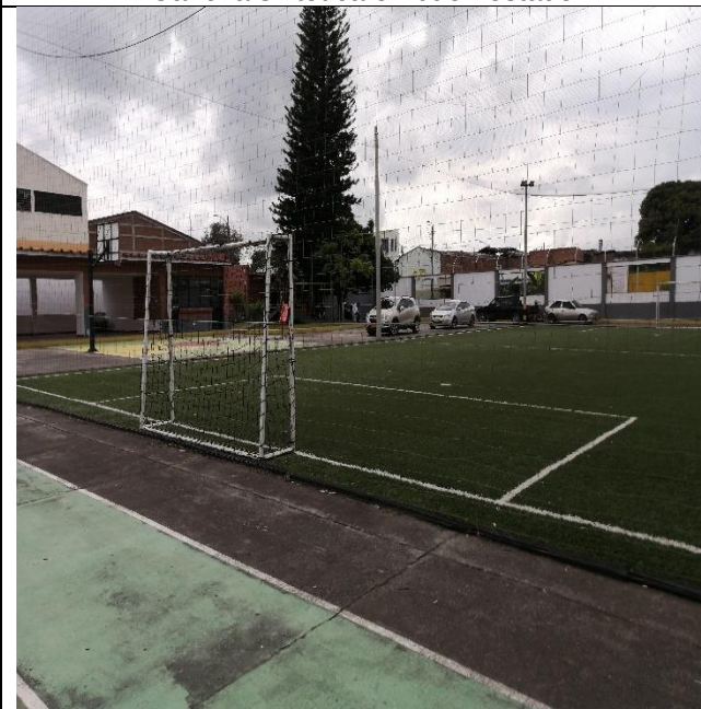
Se observan completos y funcionando todos los elementos del polideportivo.
