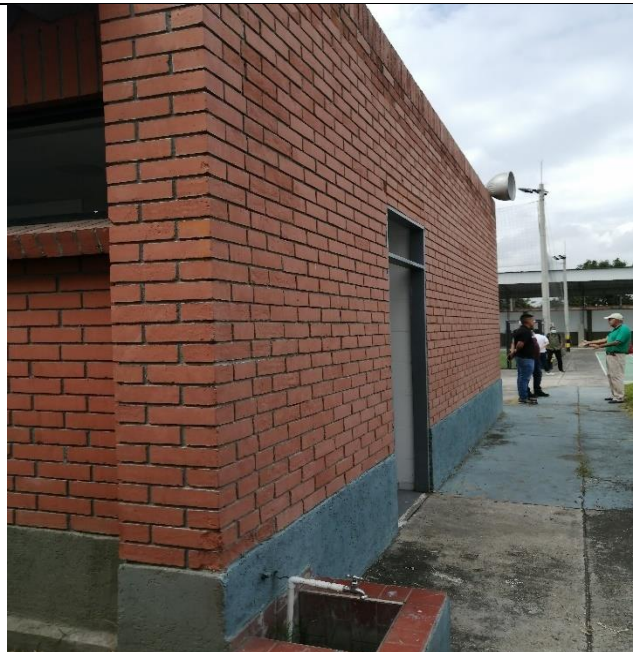
Pozo con sus respectivas instalaciones y sistema eléctrico para riego
