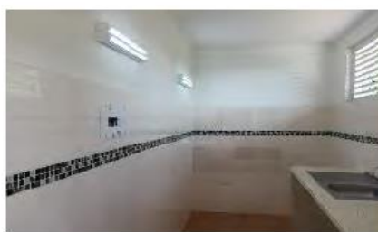
Foto N° 10: Estado Final de la Cocineta
