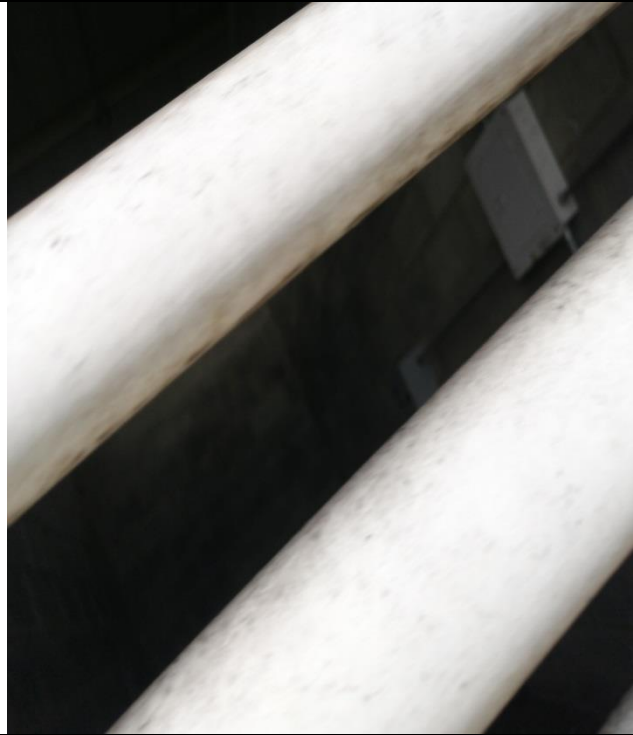
Vandalismo de las instalaciones eléctricas.
