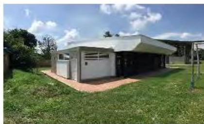
Foto N° 12: Estado Final de las Caseta Comunal
