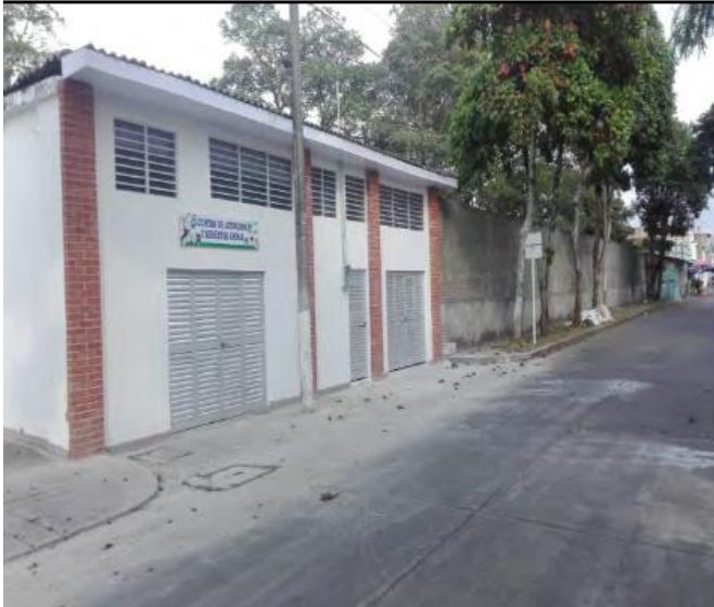
Foto No. 7 Fachada
