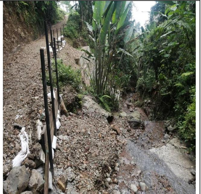
Desestabilización de la margen de la banca margen derecha de la quebrada el Oso, en el Mesón.
