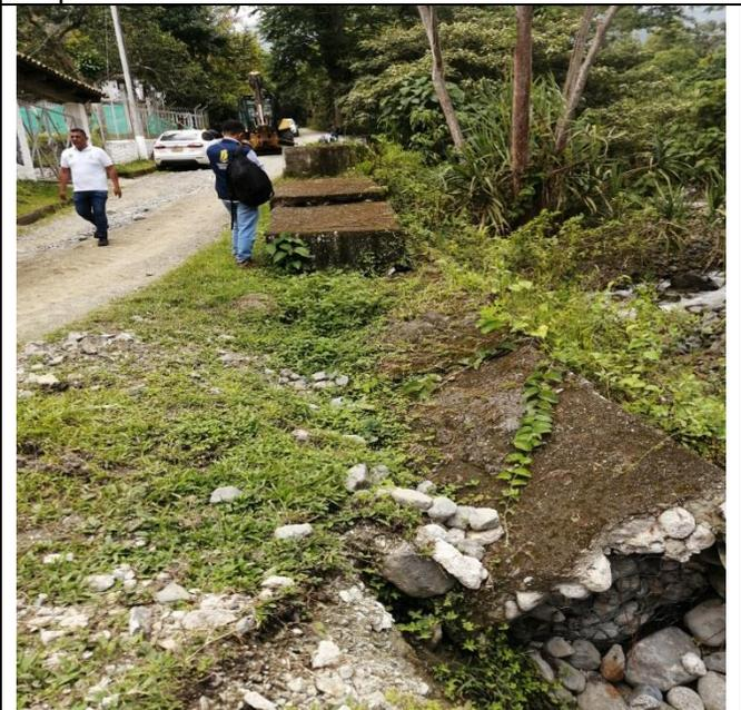
Socavación de la pata del muro en gavión existente.
