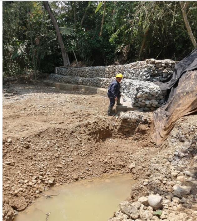
Construcción de muros de contención, tipo gaviones en área afectada por socavación del río agua clara.
