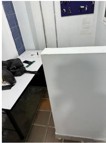
Áreas de los puestos de trabajo (cubículos) reducidas y mal distribuidas. Peligro locativos y ergonómicos en las condiciones de puestos de trabajo
