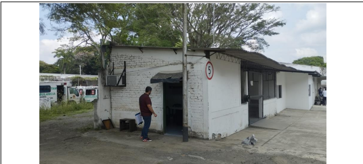
A pesar que La oficina de Atención a Víctimas comparte locación con el depósito de materiales de Gestión de Riesgo de Desastres, no se evidencia señalización preventiva para los peatones.
