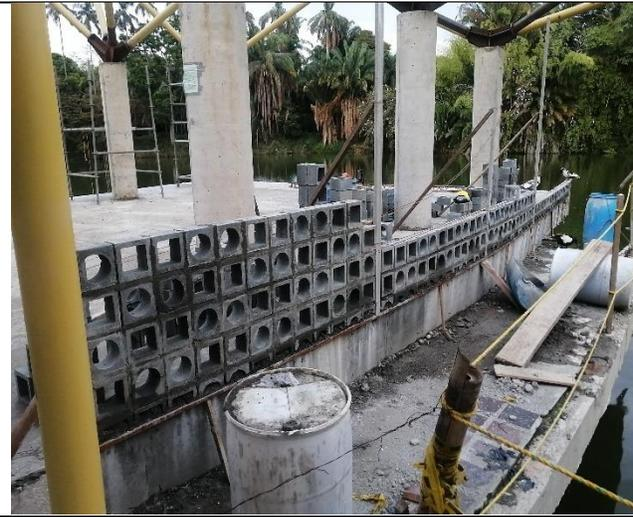
Instalación de muro calado, área lateral del restaurante
