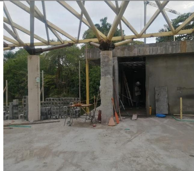
Estructura de cubierta, casi en un 80% de instalación.
