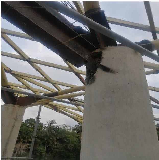
Instalación de estructura metálica de cubierta con apoyo a columna de concreto redonda.
