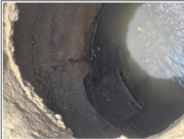
Cámara existente recibe descarga final del sistema; se observa deficiencias en el emboquillado y cámara inundada lo que indica represamiento de agua en el sistema
