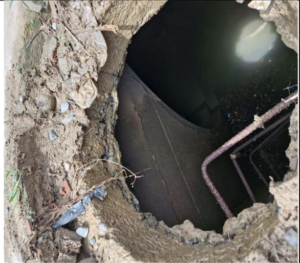
Boca de acceso a las cámaras especiales, el agua de la quebrada corre en forma continua; se observa material de arrastre sedimentado en la cámara.
