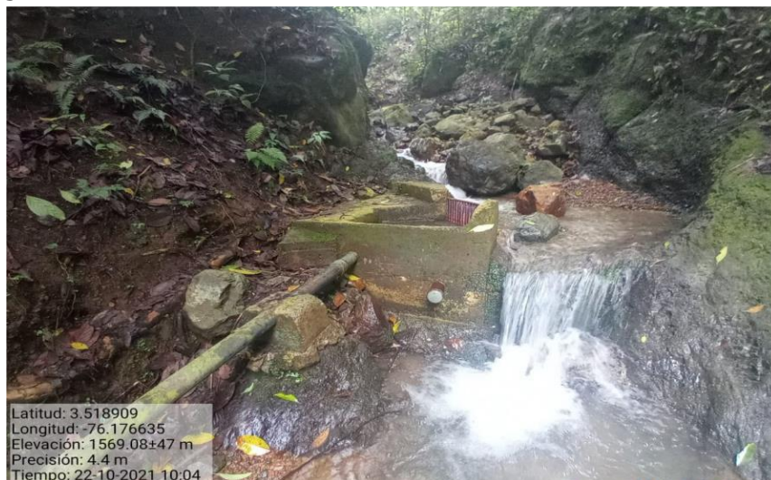
Imagen 1, Fotografía de la bocatoma Tenjo parte baja.
